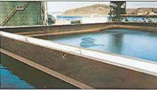
Tratamiento de aguas servidas
