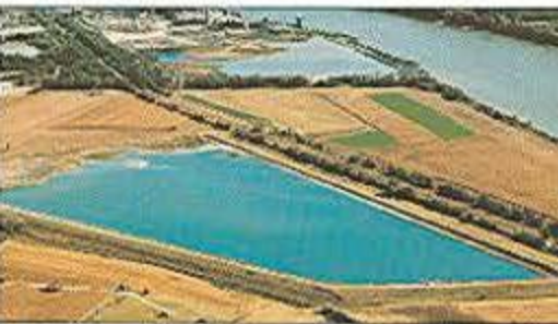
Tranque con geotextil
