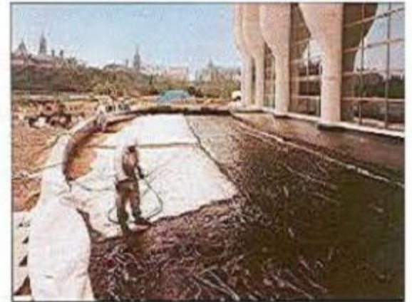
Pileta de rebalse de agua
