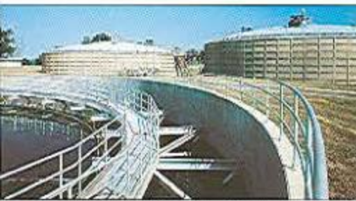
Estanque dosificador de concreto
